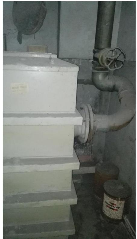
**CAUDALIMETRO, LLAVES DE EXCLUSAS, CAÑERÍA DE ENTRADA A BATERÍA DE MEDIDORES A DESAFECTAR**
