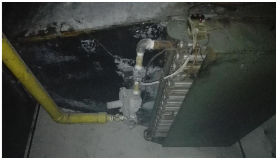
**EJEMPLO TIPO DE ALIMENTACIÓN DE GAS NATURAL A EQUIPOS DE CLIMATIZACIÓN CENTRAL TIPO ROFF TOP. EL EDIFICIO POSEE 5 EQUIPOS EN SIMILAR ESTADO DE CONSERVACIÓN Y CONEXIÓN, CUATRO DE ELLOS UBICADOS EN PLANTA DE 1° SUBSUELO Y UNO UBICADO EN PLANTA DE 2° SUBSUELO. SOLENOIDE A ENTREGAR A LA I.O.**
