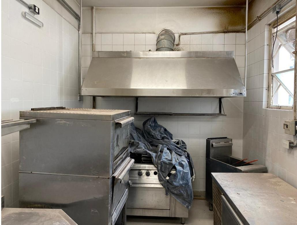
**Extracción Campana con ducto a los 4 vientos (terraza 7mo piso)**
